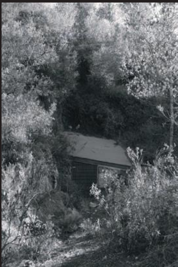
Aspecte actual de la boca de l'avenc de Fondegulla, cobert amb un sostre i una reixa que permet l'entrada de l'aigua de les riuades i alhora evita que es llancen brutícies o es produïska algun accident.
