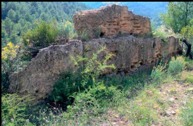
Llenç meridional de la muralla del castell de l'Alcúdia de Fanzara,
